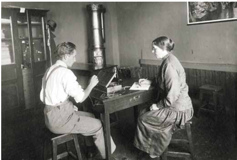
Psykotekniske prøver ble tatt i bruk ved Oslo Haandverksforskoler i 1925. Her foretas en støhetsprøve på en elev ved hjelp av et såkalt tremometer. Hensikten var å «prøve håndens arbeidsanlegg», som psykologen Helga Eng formulerte det i 1928 i Psykoteknikkens anvendelse i Norge . FOTO: UKJENT / OSLO BYARKIV.
